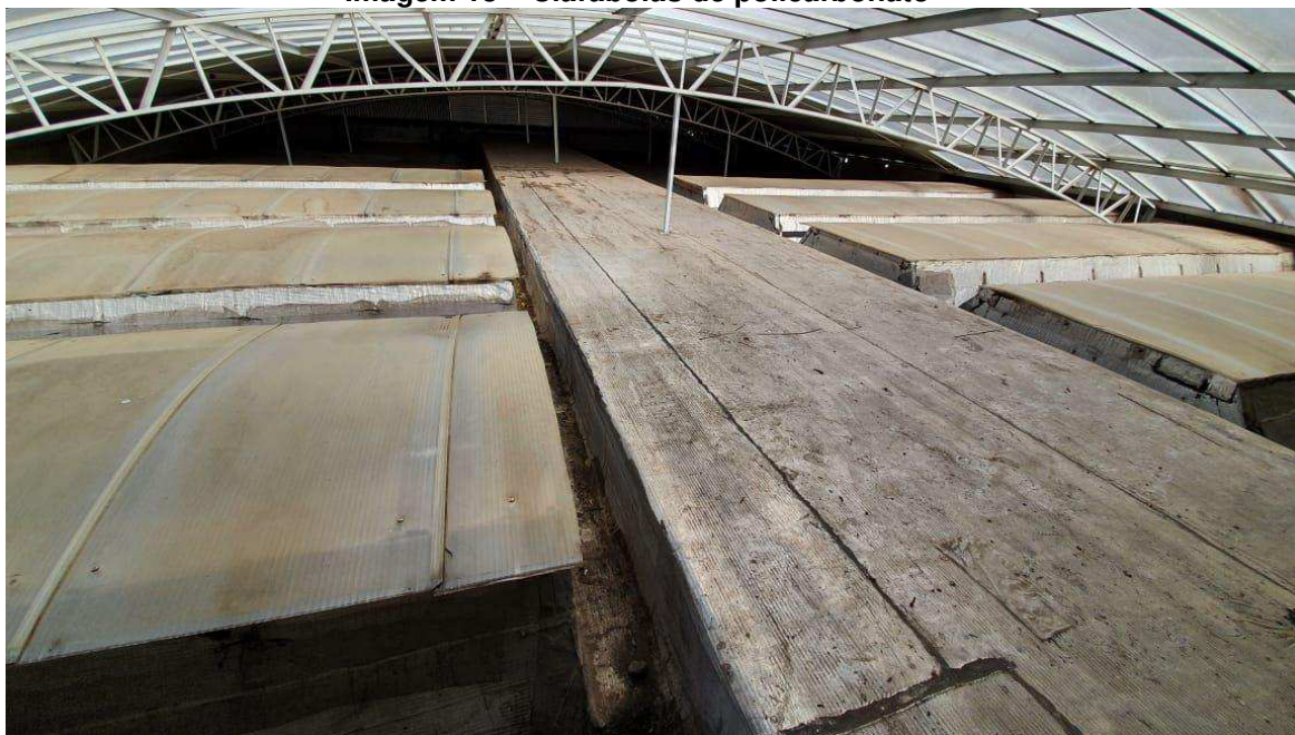
Imagem 18 – Claraboias de policarbonato
