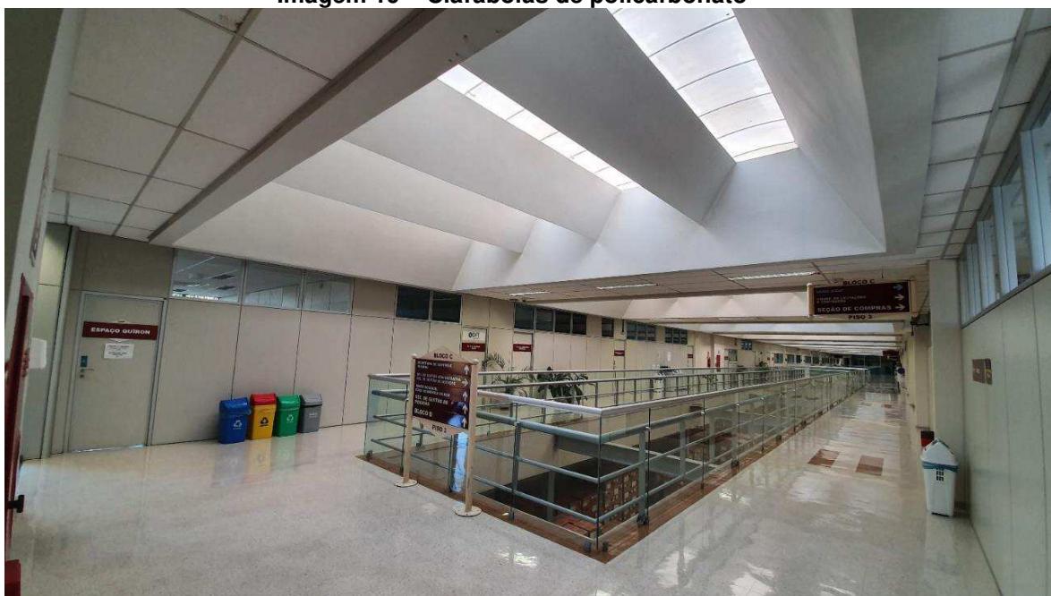
Imagem 19 – Claraboias de policarbonato
